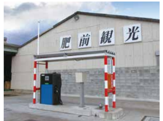
「地下給油装置」を設置して、自社で給油できる体制を構築
